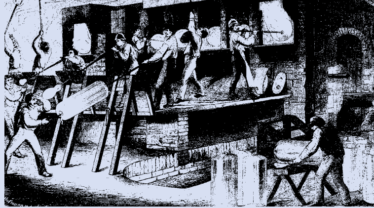
Ehemalige Wohnhäuser der Glasmacher Flachglasherstellung im Walzenverfahren
